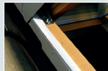
Il raccordo per la finestra KLIMA è di dimensioni maggiori, per consentire l'inserimento di materiale coibentante a completamento della prestazione termica. I carter di copertura sono coibentati, nella parte interna, per evitare gocciolamenti di condensa esterna.
