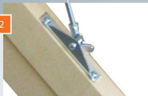
2 Il meccanismo di sostegno consente la normale apertura da 0° a 45°. Con lo sblocco del meccanismo possiamo arrivare ad apertura di 90° con opportunità di bloccare l'anta aperta.
